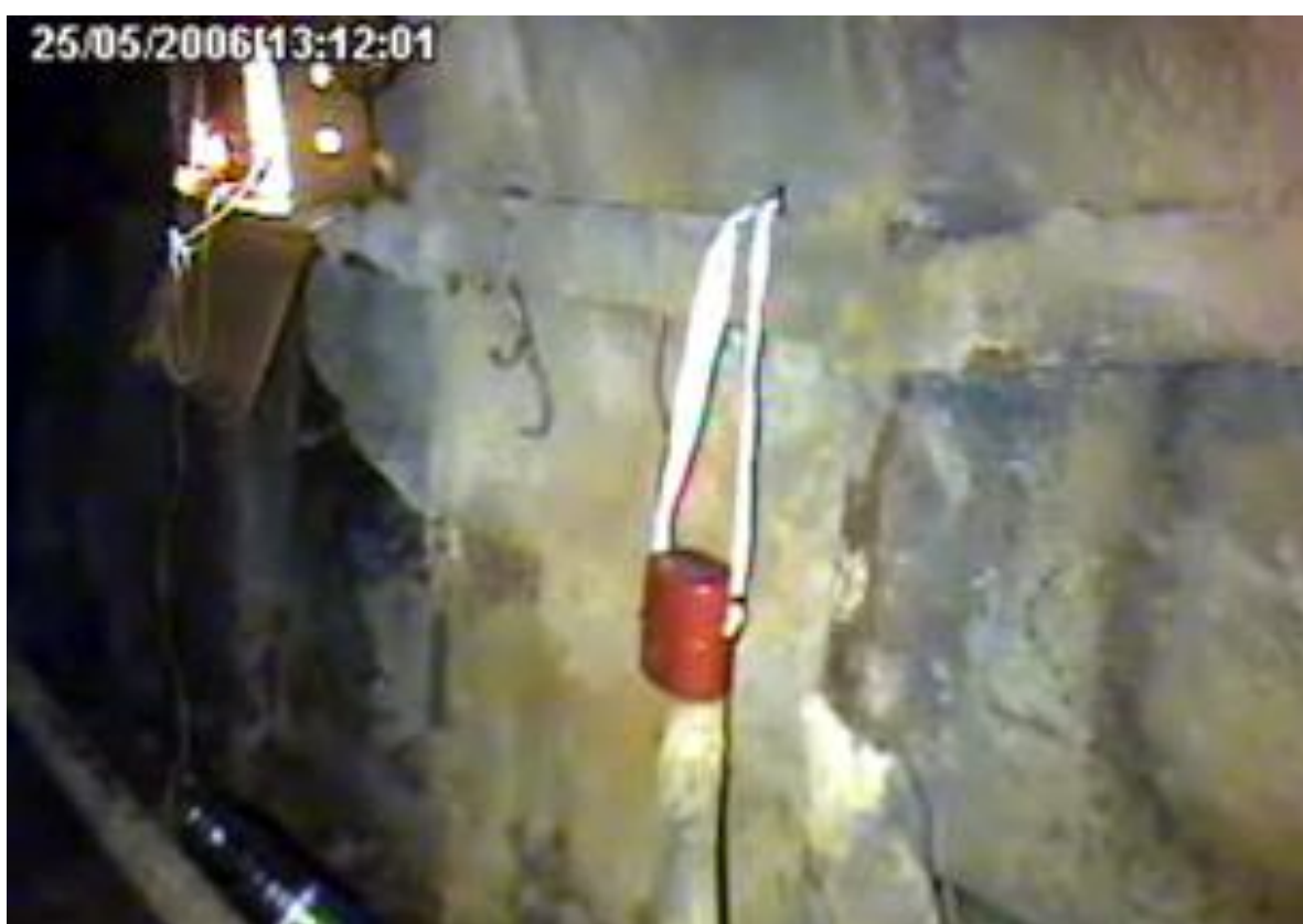
Изображения, полученные наземной стороной от подземной стороны по шахтной проводке длиной 5000м
